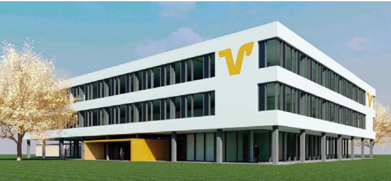
Eröffnung 2015: Das neue Verwaltungsgebäude der Volksbank Breisgau-Süd
